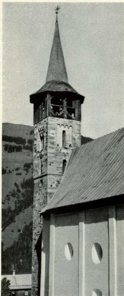
Abb. 335. Andest.—Katholische Pfarrkirche. Ansicht des Turms von Westen.
